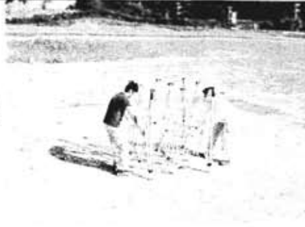
② 下側のV字部分を持ち上げながら外側に引っ張り、フレームを半ばまで広げます。
